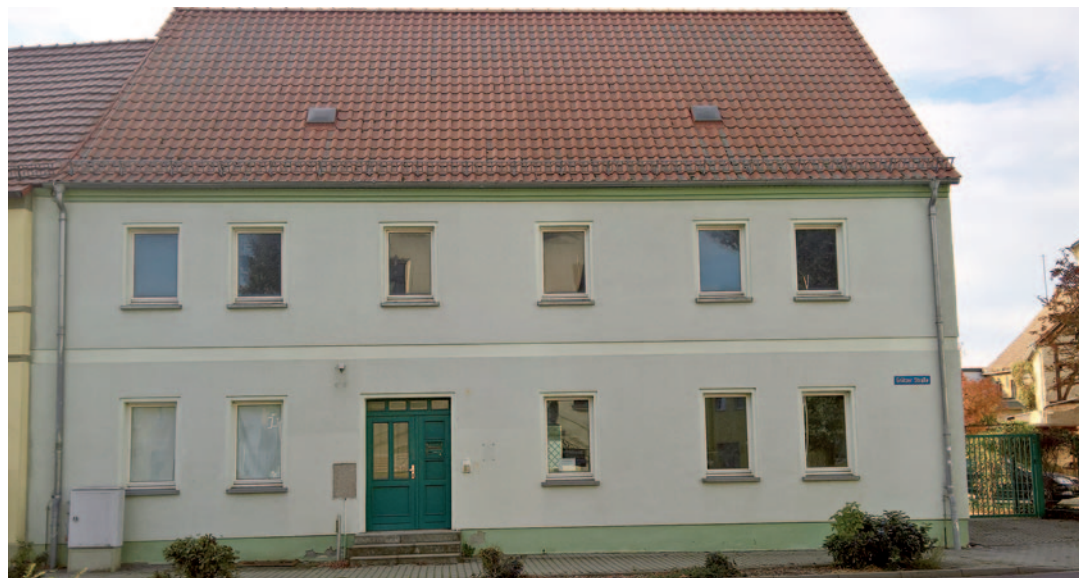
Das Haus Grätzer Straße 6 in Möckern wird Teil der Verwaltung. Die Mittel für den Umbau sind bewilligt.
